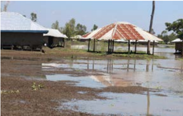
Hunderte von Lehmhütten wurden durch die Überschwemmungen seit Beginn 2020 im Bereich Ombaka, einem Nachbarort von Kasuna, restlos zerstört und die Familien obdachlos
